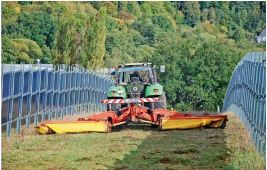
Die erste kommerzielle Anlage von Next2Sun befindet sich im saarländischen Dirmingen. Sie liefert zweimal täglich Strom und entzert somit Lastspitzen. Das Grünland wird bewirtschaftet.
